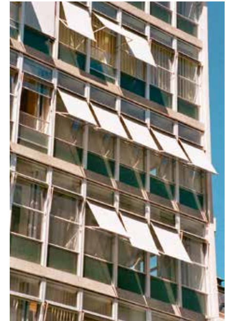
Installation des nouveaux panneaux, septembre 2004.
