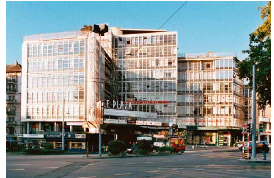
Mont-Blanc Centre pendant les travaux, septembre 2004.
