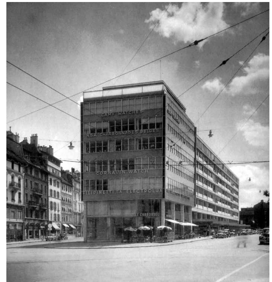
Terreaux-Cornavin, le bâtiment terminé.
