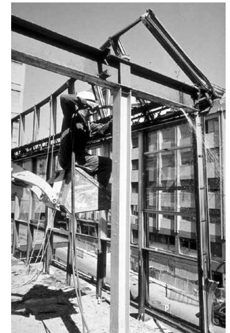
Le bâtiment en cours de démolition, septembre 1987.
