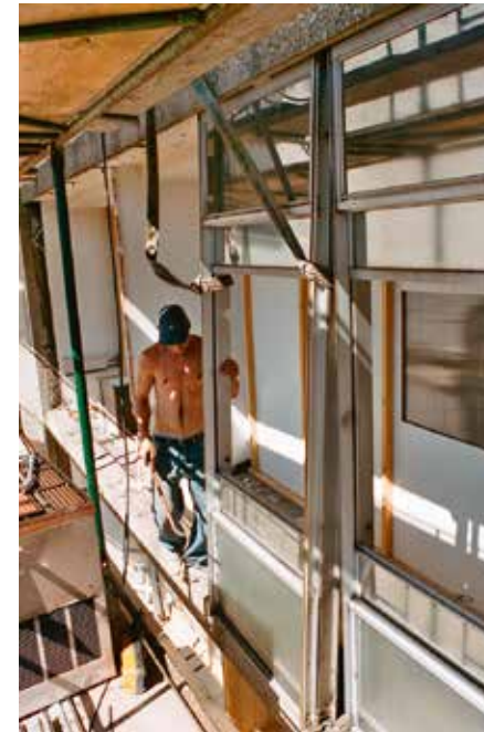
Démontage des panneaux de Mont-Blanc Centre, septembre 2004.
