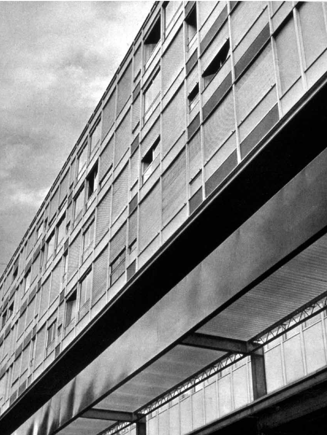
Gare-Centre, le mur-rideau vers 1957.
